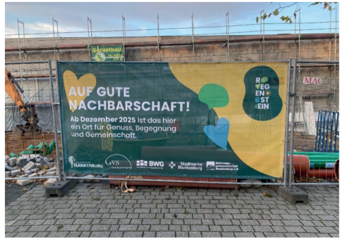
In der Karl-Zerbst-Straße wird fleißig gebaut. Der neue Supermarkt mit Bäcker und Cafetheke ist bald fertig.
